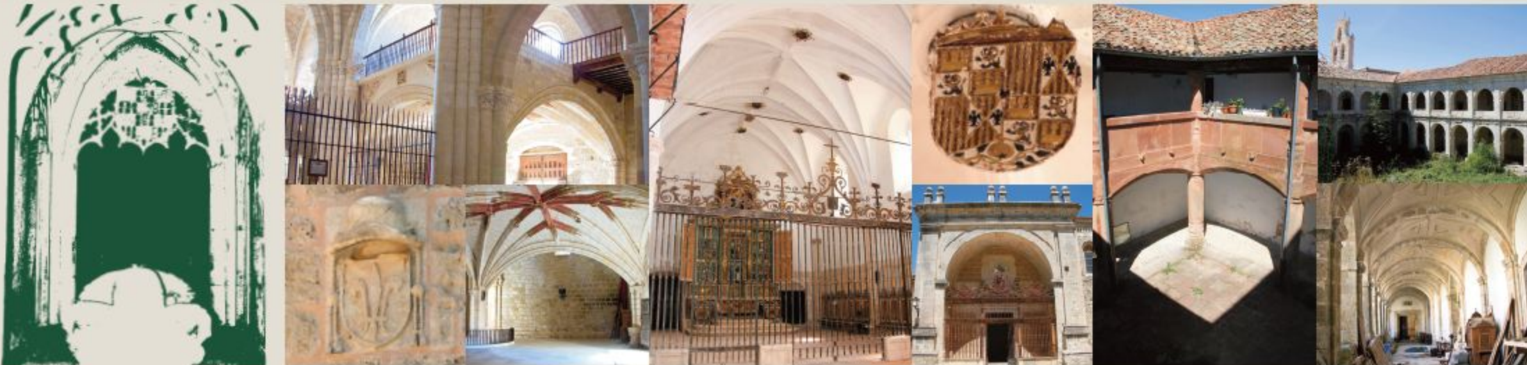
Detalles interiores y exteriores de las zonas construidas desde los siglos XV al XVII en el Monasterio
