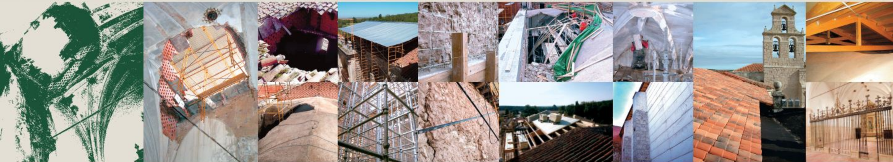
Detalles de las obras de consolidación estructural y reposición de bóvedas y cubierta en la capilla del Santo o de San Nicolás
